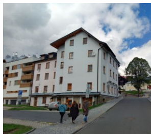
Pohled na objekt z nižší úrovně terénu
