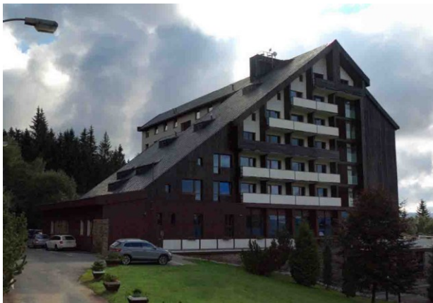
OREA Wellness Hotel Horizont – Pancíř Ukázka realizace stavby s větším počtem podlaží v podkroví. Celkem 6 podlaží umístěných v podkroví.
